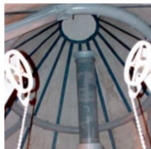
Вид конуса силоса изнутри
