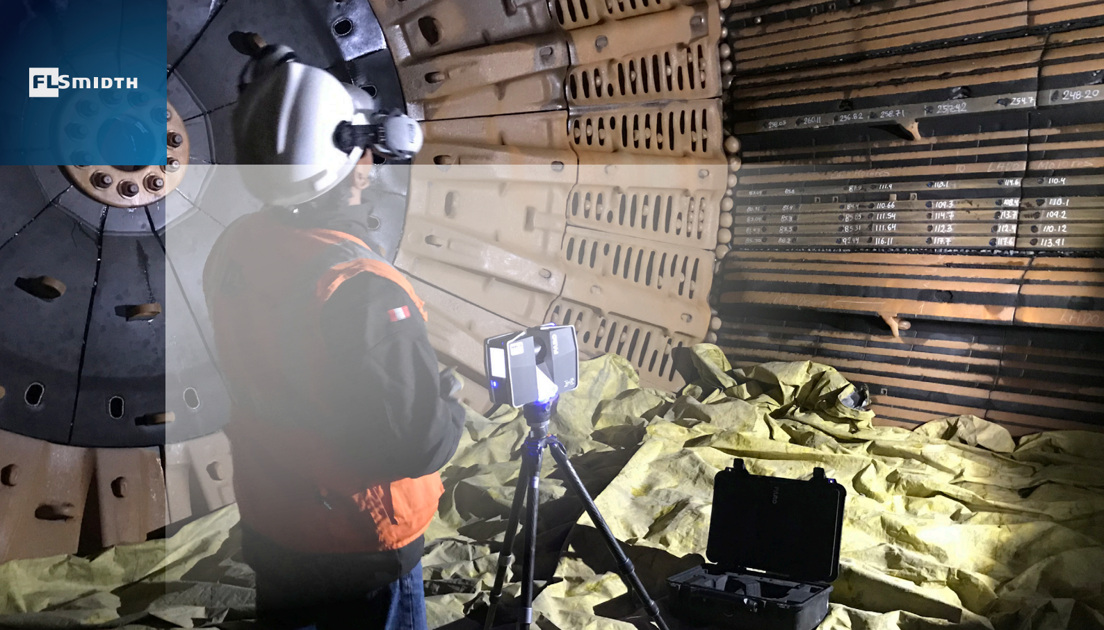
Escaneamento 3D utilizado para examinar o desgaste dos revestimentos.
