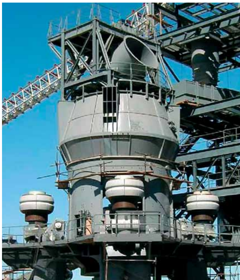
Мельница ОК 36-4 в процессе монтажа
