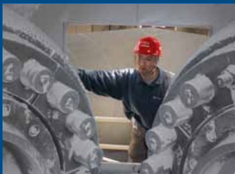
Осмотр мельницы шлака
