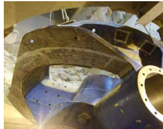
Actual Installation of the Crusher
